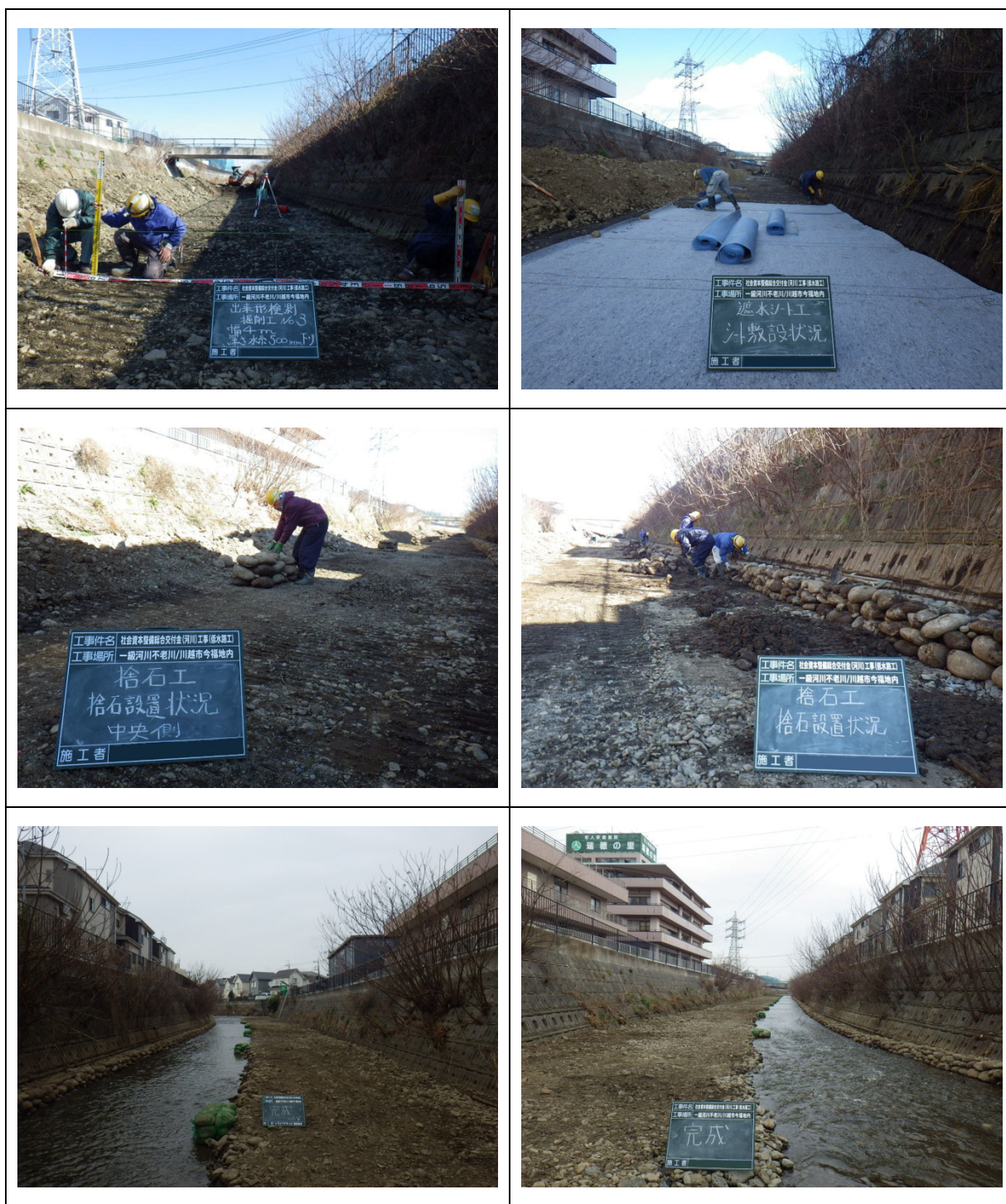
図 5.3 工事中および竣工時の状況
