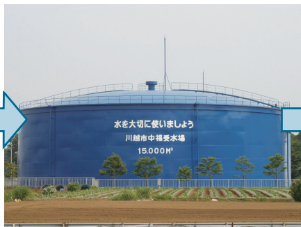
配水池 (はいすいち) 水道水を配水池にためます
