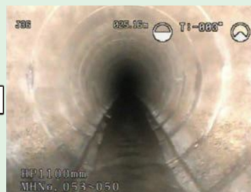
管内カメラ調査
