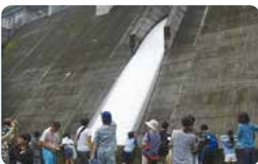
合角ダム 放水の様子
