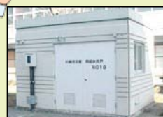
災害用給水井戸
