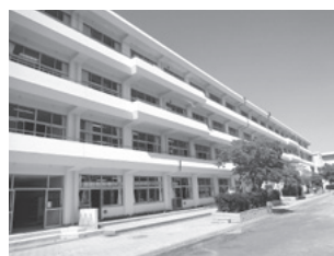
平成 29 年度に大規模改修工事を実施した川越小学校
