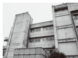
小中学校大規模改造工事の推進
