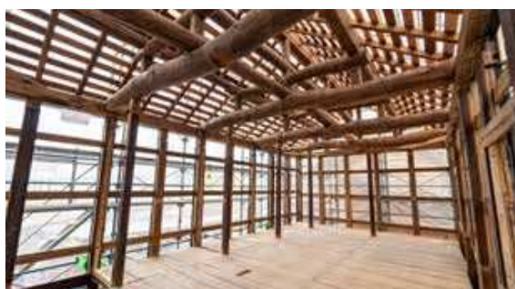
店蔵2階（木工事完了）
