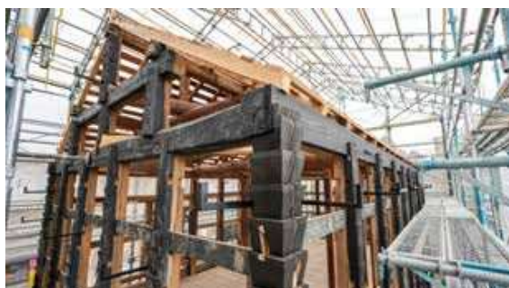
店蔵外観（木工事完了）
