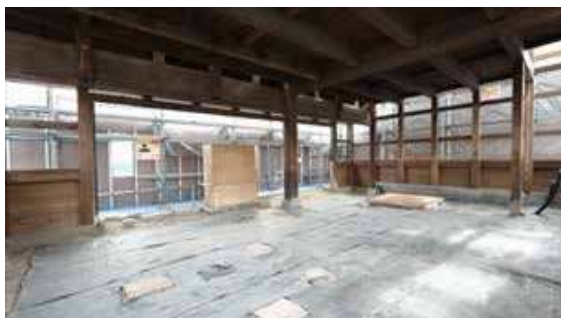
店蔵1階（木工事完了）
