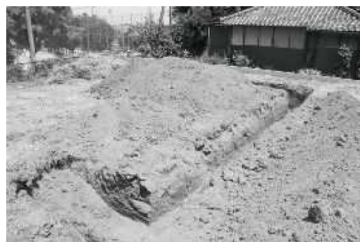
トレンチ掘削状況(南西から)
