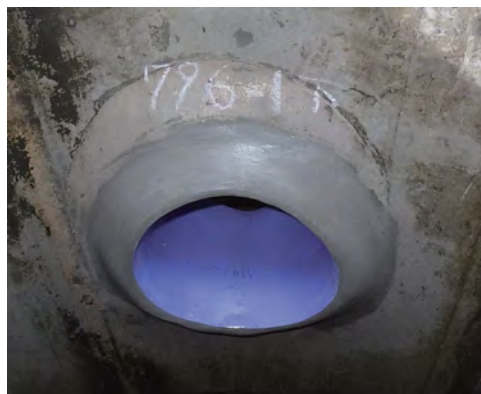
污水管きよ更生工事（施工後）
