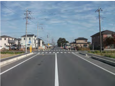
拡幅中の広域幹線道路 （市道 0023 号線）
