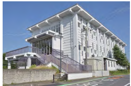
耐震改修後の武道館
