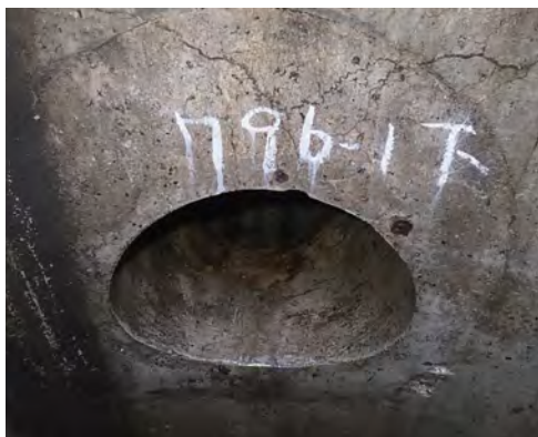
污水管きよ更生工事（施工前）
