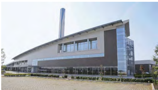
環境プラザ「つばさ館」
