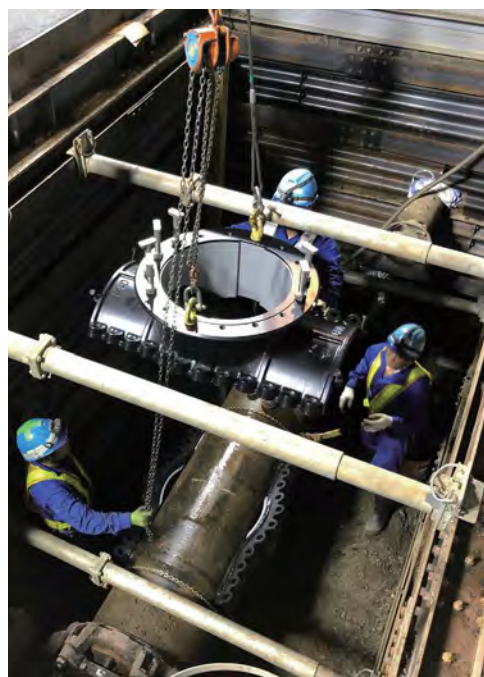
不断水バルブの設置工事
