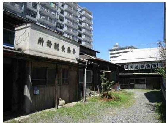
解体前の状況
