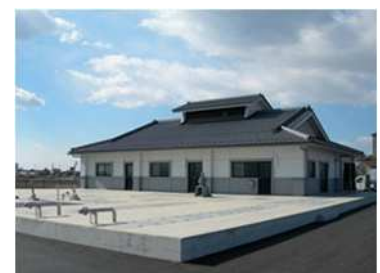
鴨田農業集落排水処理施設
