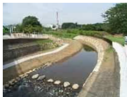
多自然型護岸(笠幡地区)
