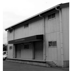
宮下町1丁目に設置されている宮下災害備蓄庫
