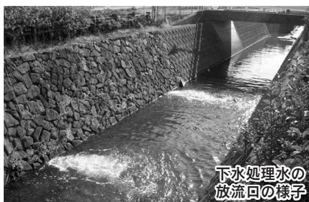
平成10年度に、不老川下流に位置する滝ノ下終末処理場（現在の新河岸川上流水循環センター）から送水ポンプによって12km上流の不老川（狭山市南入曽地内）へ、39,000m<sup>3</sup>/日の下水処理水の放流を開始しました。同13年度には、同センターに隣接する川越浄化プラントが完成し、さらに高度処理された下水処理水が放流されるようになりました。また近年、下水処理中のアンモニア性窒素の除去にも成功し、不老川の水質改善は大幅に進展しました。
