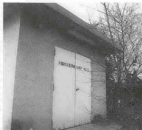
災害用給水井戸を増設
