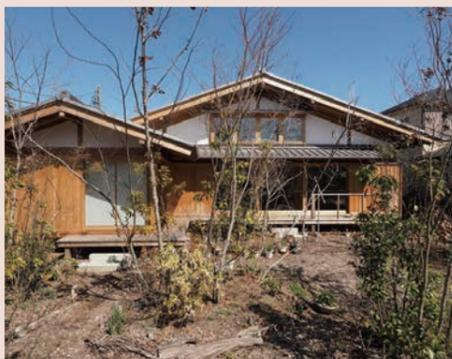
住宅地の一角に、川越の原風景を思わせる雑木に囲まれた気候風土適応型の木造住宅が新築されました。伝統的な石場建て工法を用いた建物は、土壁を用いることで断熱性や調湿性にも優れた性能と快適性を持ち合わせています。自然浸透工法を採用した、舗装せず土を残したオープンな庭づくりは、四季折々の表情をご近所にも提供してくれます。建物が主役でありつつも、景観形成における植栽の有効性を示すお手本のような事例であると言えるでしょう。建て主の環境への意識の高さと伝統的な構法を継承していこうという作り手の熱意が受け取れる建物です。
