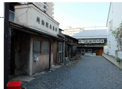
旧栄養食配給所
