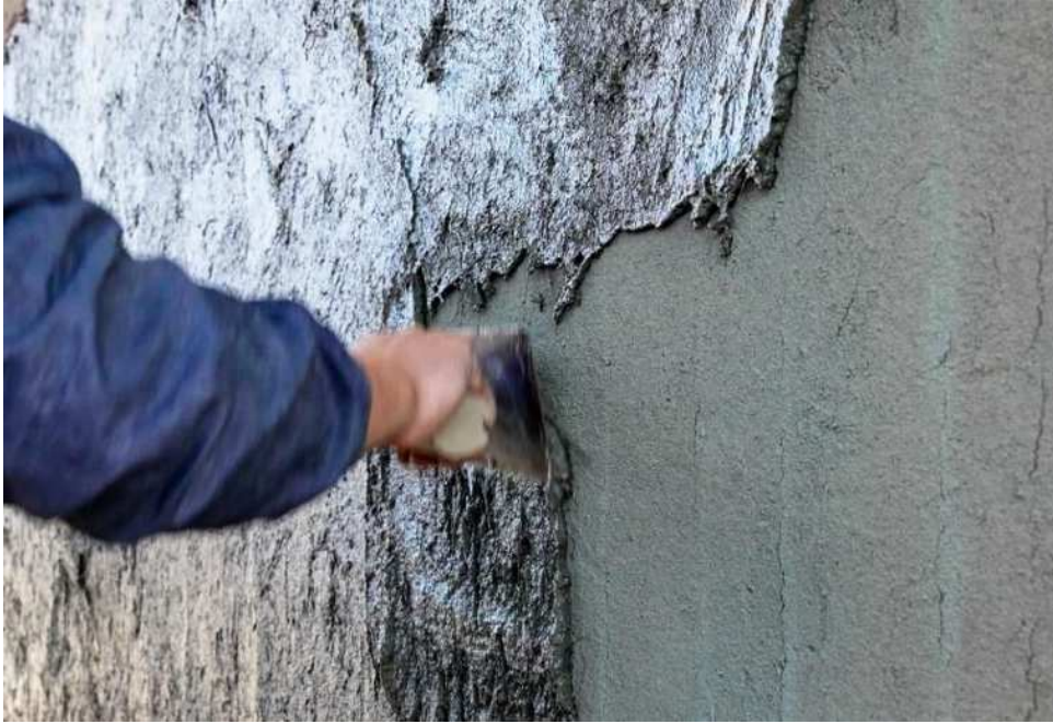
砂摺りを行い横縄入れの土が定着しやすくする(外壁)
