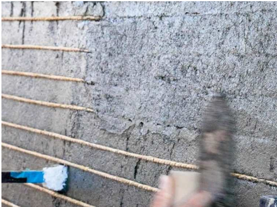
架け渡した横縄を埋め込むように塗っていく(外壁・横縄入れ)
