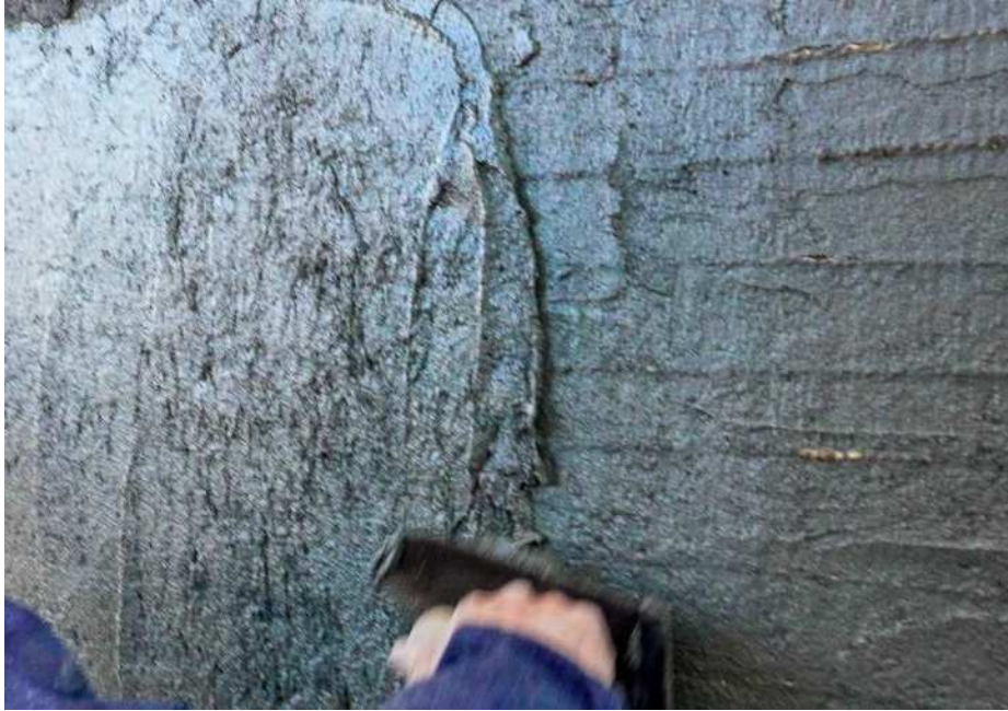
縄隠しのためさらに土を塗り付け乾燥養生となる(外壁・横縄隠し)
