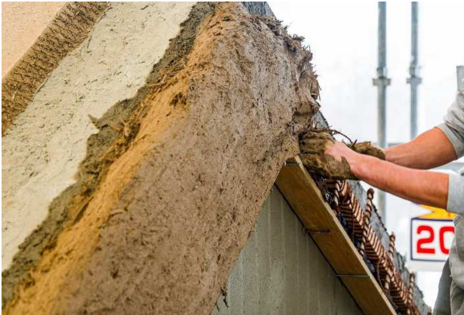
屋根下部で斜めに張り出す鉢巻の下地(荒打ち)
