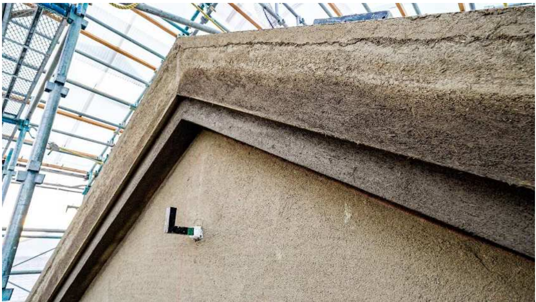
縄入れ後の縄隠しで鉢巻下地の完了
