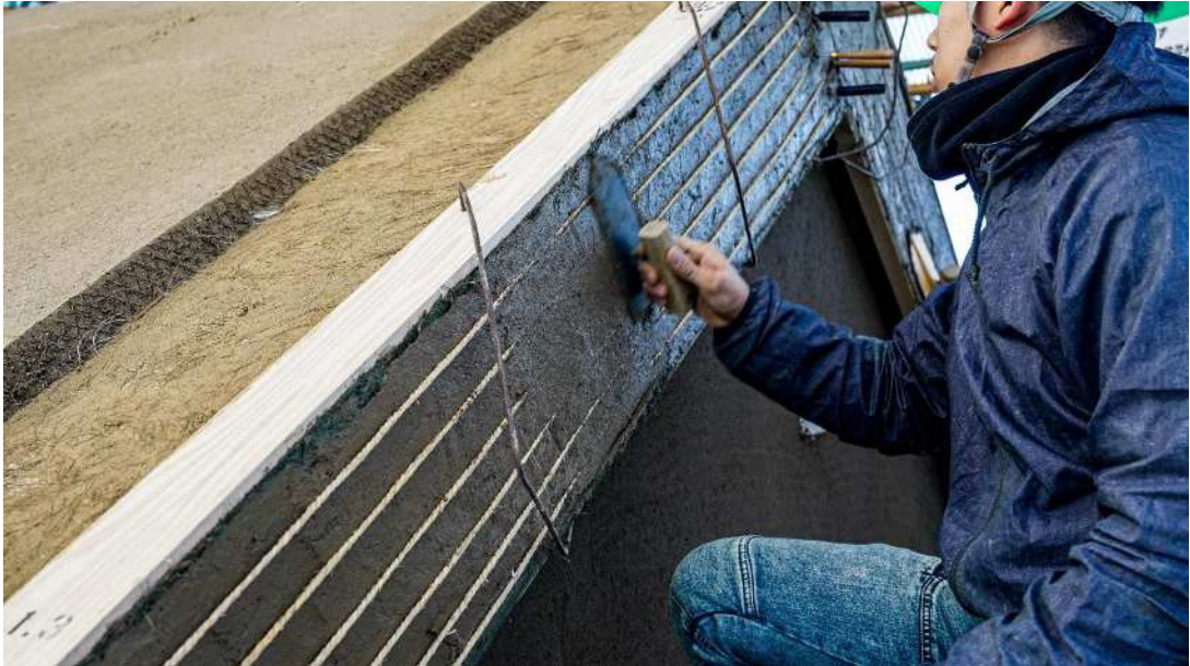
土を定着させるため横縄を入れ込む(鉢巻縄入れ)
