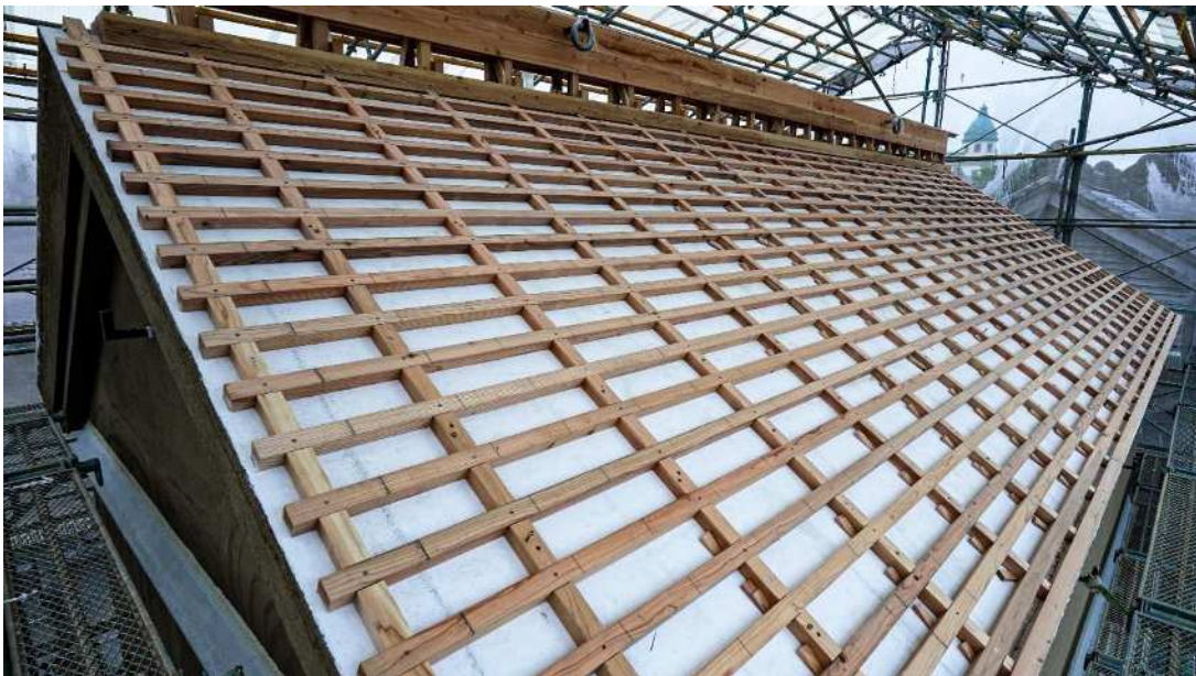
屋根土居塗漆喰仕上げの上に瓦棧設置・箱棟下地完了(最上部)
