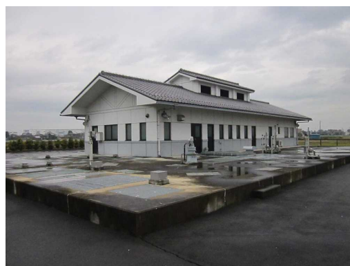
石田本郷農業集落排水処理施設
