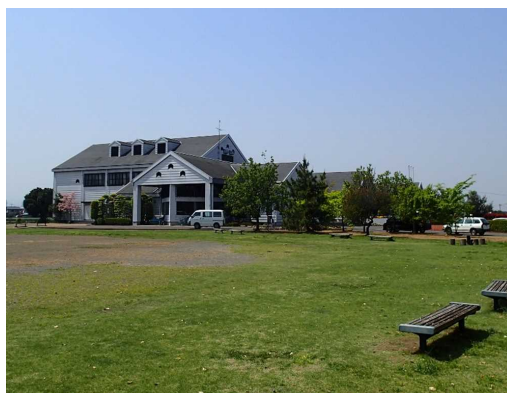
グリーンツーリズムの拠点施設として改修を予定している農業ふれあいセンター
