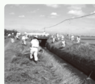
水路法面の草刈り
