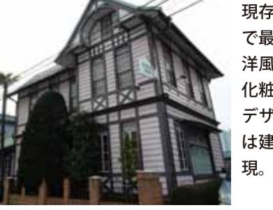
現存する洋館建築としては川越で最も古い、大正2年（1913）築。洋風下見板と構造体である柱を化粧したスティックスタイルのデザインが特徴で、現在の外壁は建築当初と考えられる色を再現。
