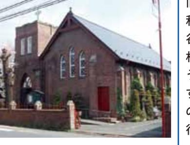
レンガの教会として親しまれている日本聖公会川越キリスト教会礼拝堂。市内唯一のレンガ造建築。立教大学の礼拝堂なども手がけたアメリカ人建築家W. ウィルソンの設計で、外壁（主壁）を外から支持・補強するバットレス構造が特徴です。
