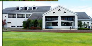
拠点となる農業ふれあいセンターの改修 (令和3年度)
