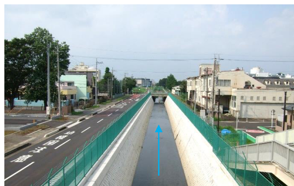
台風第21号により崩壊した護岸の災害復旧（平成31年2月完成）
