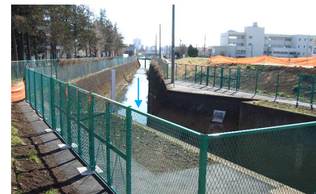
樋門部フェンスを応急排水作業用門扉等に改修（平成31年3月完成）
