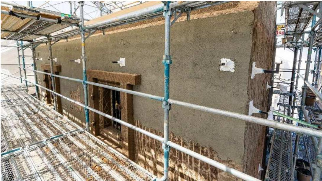
荒壁を平らにしていくため砂摺りの土を塗る(縦縄入れ)
