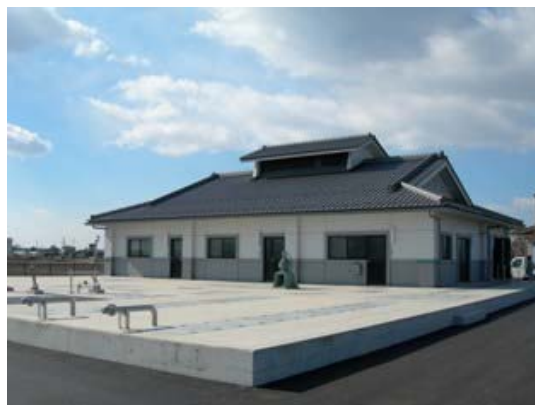
鴨田農業集落排水施設
