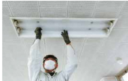
① 蛍光管をはずす。
