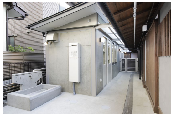
外観（東水廻り棟）
