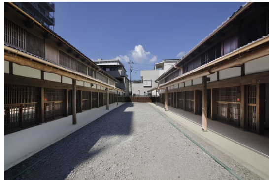
外観（中庭空間）
