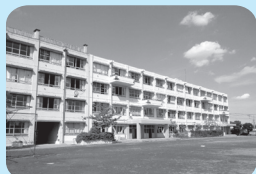
初雁中学校の校舎外壁
