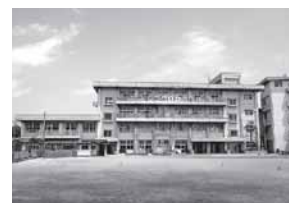
南古谷小学校増築
