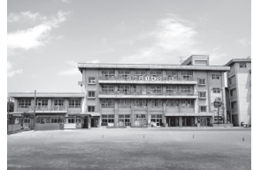
南古谷小学校増築
