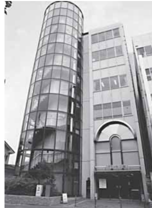
川越駅東口図書館
