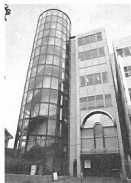
川越駅東口図書館
