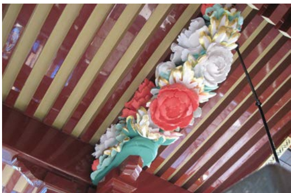
拝殿向拝手挟彫刻・彩色補修状況（下から）
