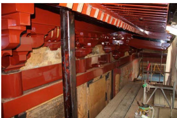
本殿西面軒廻り・漆塗上塗後（北西から）
