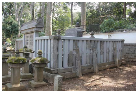
建中院廟・整備工事後（北西から）
