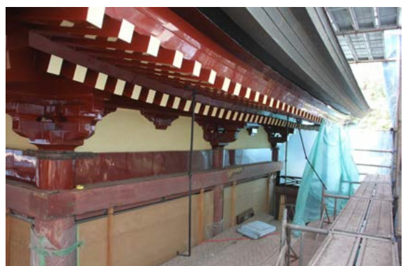
拝殿東面軒廻り・漆上塗後（南東から）
