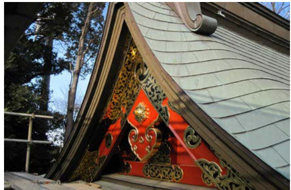
本殿西入母屋破風・修理完了（南西から）
