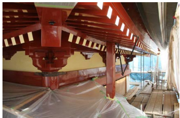
拝殿西面軒廻り・漆上塗後（北西から）
