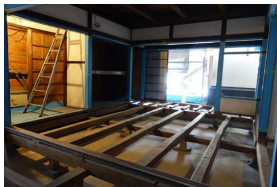
住居棟 床解体状況
