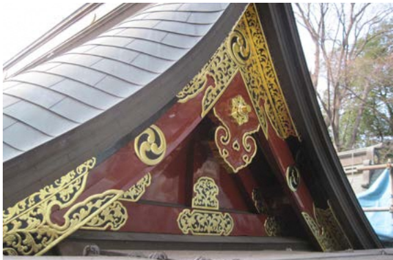
拝殿東入母屋破風・修理完了（南東から）
