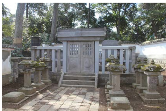
建中院廟・整備工事後（北から）
