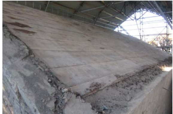
第1期工事完了後
