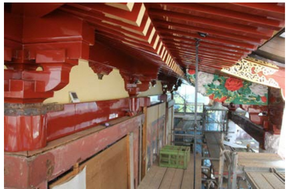
拝殿正面軒廻り・漆上塗後（西から）
