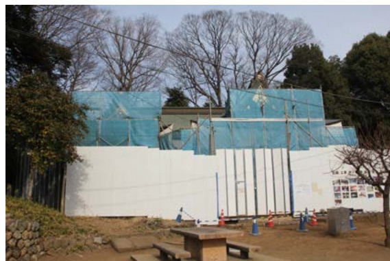
仮囲い設営状況（西から）
