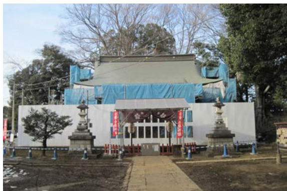
仮囲い設営状況（南から）
