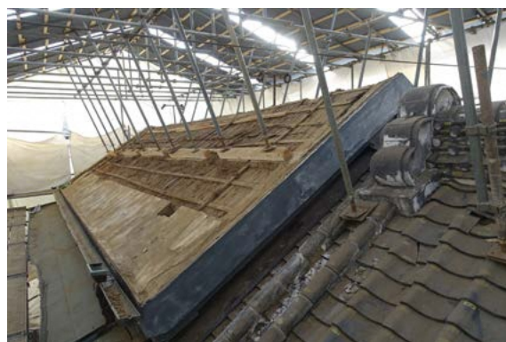
店蔵 屋根解体状況
