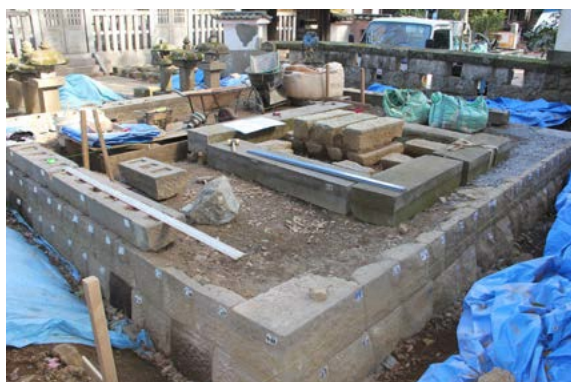
建中院廟・整備工事中（南西から）
