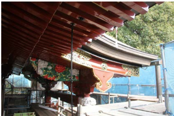
拝殿向拝軒廻り・漆上塗後（西から）
