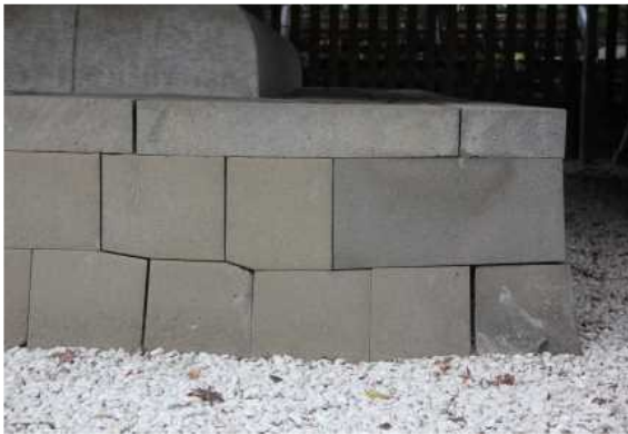
写真1 (修理前のズレ等の状況)
