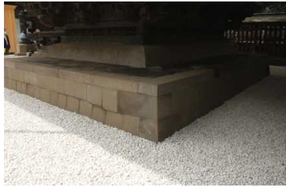
写真2 (修理後の様子)
