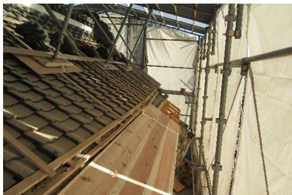
崩落した鉢巻部分の上部の屋根下地を新調し、新しい瓦を葺く
