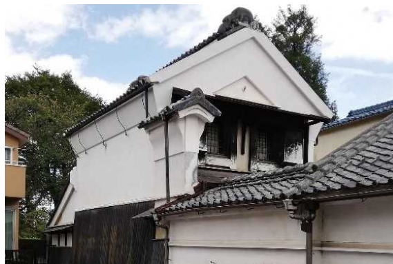
工事終了後の状況
