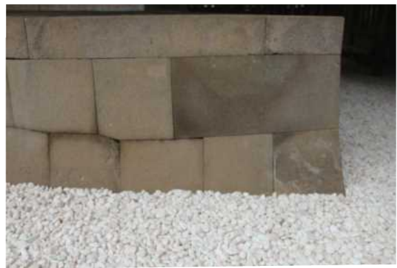
写真1 (修理後の様子)
