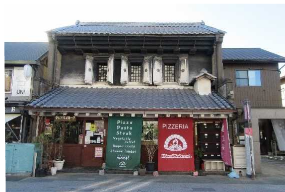
工事後の外観
