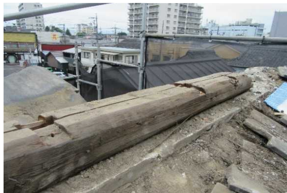
棟のトタンを外し、元の棟の土台部分を確認
