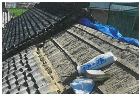
古い屋根瓦と土を除去する
