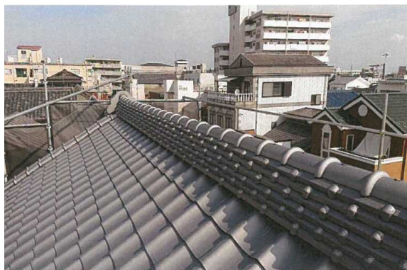
新しい屋根瓦と棟の熨斗瓦
