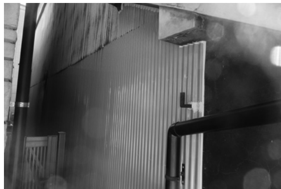
工事後の外観（トタン壁の新調）
