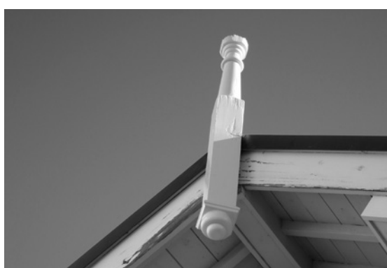
工事後の修理部分
