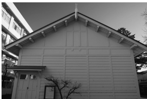
工事後西側側面部分
