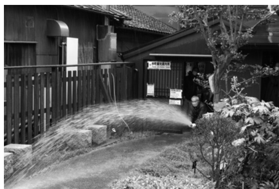
埋設式簡易型屋外消火栓の操作訓練
