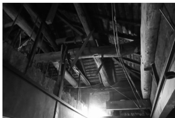
第1期工事完了後理後
