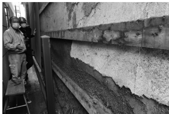
東側のトタン壁を剥がし壁の様子を確認する
