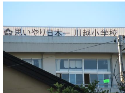
校舎屋上柵（北側）に設置しました
