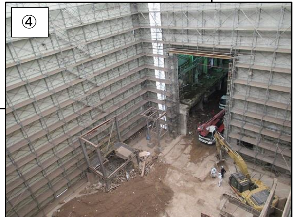
仮設テント内部の様子です。(機器の解体撤去が完了しました)
