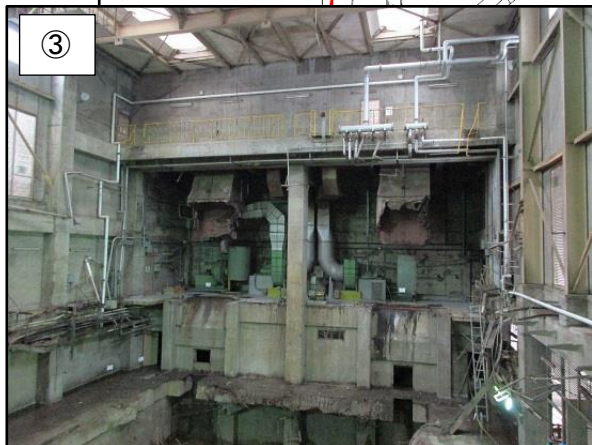
焼却炉本体の洗浄・解体撤去が完了しました。
