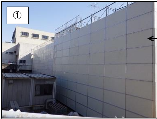
不燃物処理棟の解体前の様子です。 解体に先立ち、仮設足場を利用して 防音パネルを設置しました。
