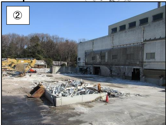
不燃物処理棟の解体中の様子です。
