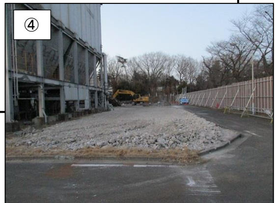
東側の附属施設を解体した後の様子 です。
