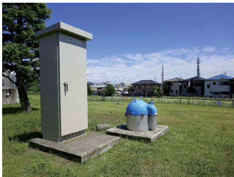
郭町浄水場第1水源
