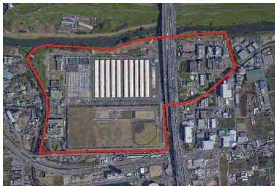
新河岸川水循環センター
