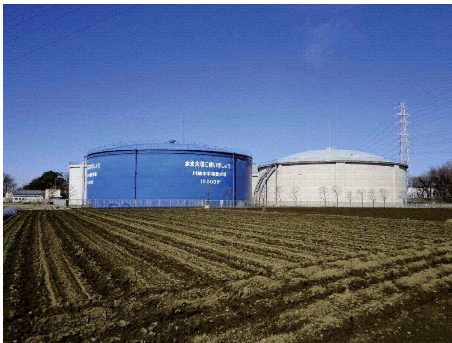
中福受水場配水池
