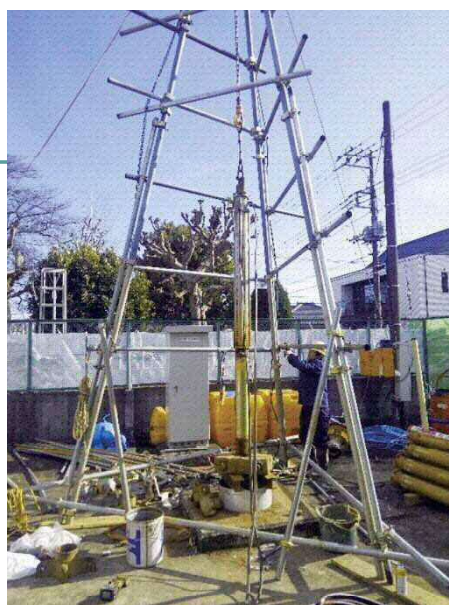
井戸修繕の様子
