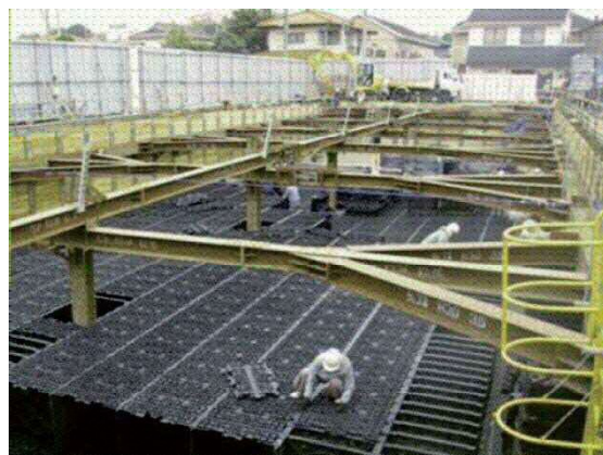
雨水貯留施設の整備
