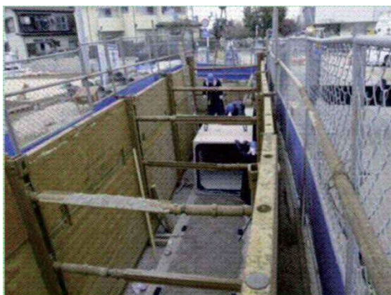
雨水管きよの整備
