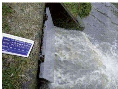
雨水吐口（雨天時）
