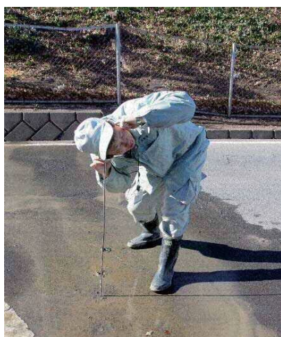
音聴棒を使った漏水調査
