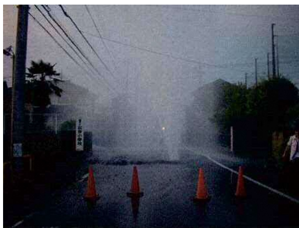
2008年8月の漏水状況
