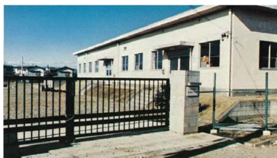
霞ヶ関第一浄水場
