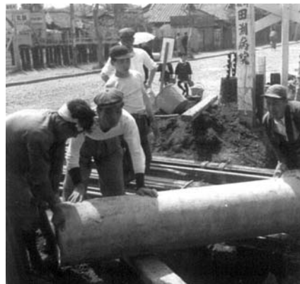
配水管布設工事の様子
