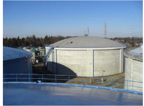
中福受水場の配水池
