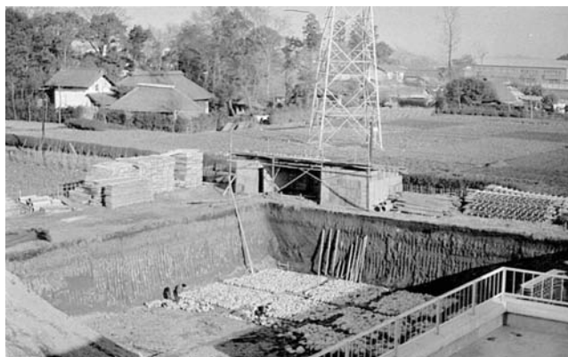
新宿浄水場建設工事の様子
