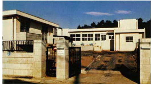
建設当時の霞ヶ関第二浄水場
