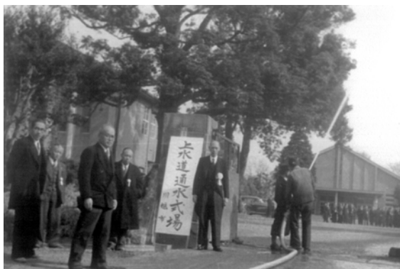
水道創設時の様子（通水式）
