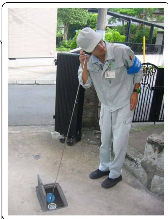
漏水調査の様子
