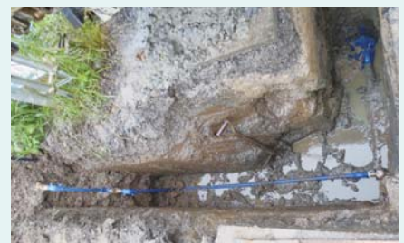
↑給水管引き込みの様子
