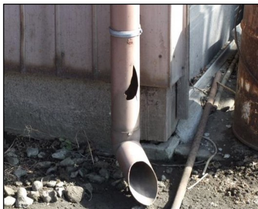
写真 26 軒・雨樋の事例①
