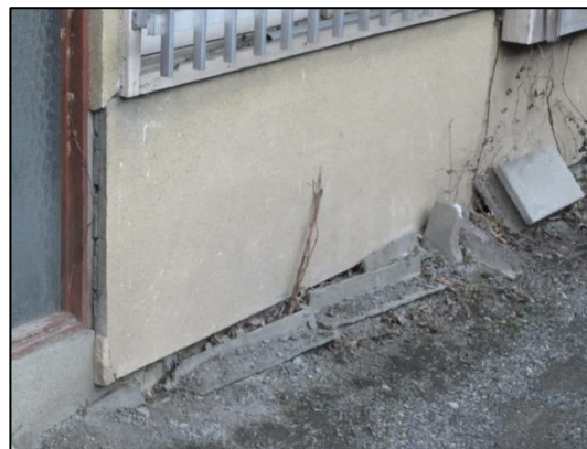
写真 19 基礎・土台の事例
