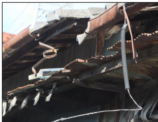
写真 27 軒・雨樋の事例②
