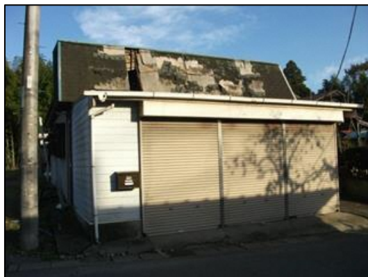
写真 20 屋根の事例①
