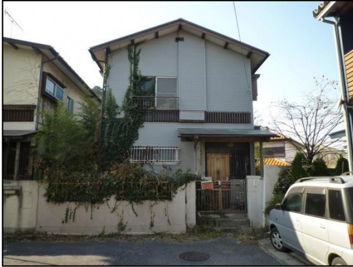
写真1 対象建物の全景
