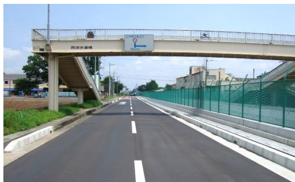
災害復旧に伴う都市下水路西側道路の復旧(令和元年6月完成)
