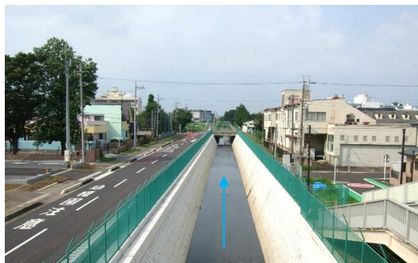
台風第21号により崩壊した護岸の災害復旧(平成31年2月完成)
