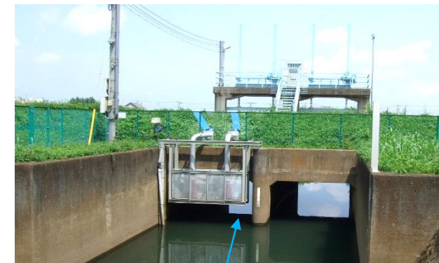
樋門部に応急排水ポンプ(毎分8立米)を7月から12月まで設置(令和元年7月完成) ≪参考≫ 川越市排水ポンプ車の排水能力(毎分30立米)
