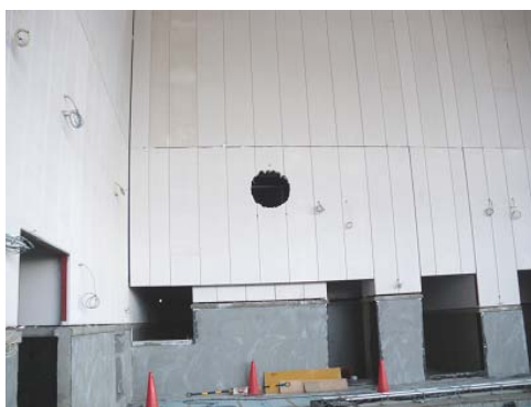
②プール 間仕切壁
