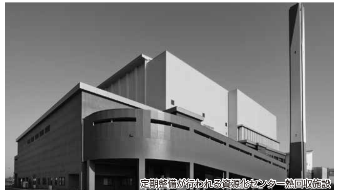
定期整備が行われる資源化センター熱回収施設
