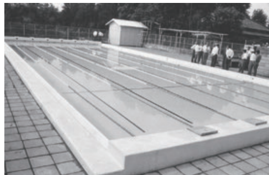
完成した霞ヶ関小・中学校の共用プール
