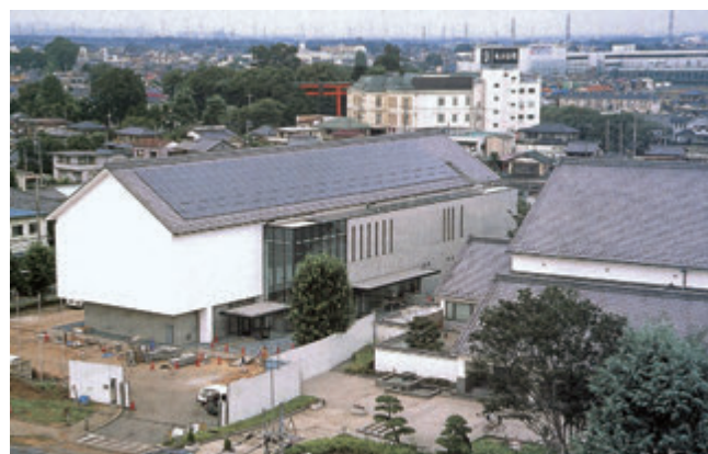
完成間近の川越市立美術館
