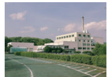
西清掃センター(平成22年3月稼働停止)
