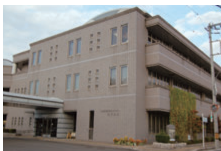
完成した総合福祉センター
